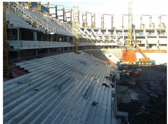
Figura 2.- Nuevo Estadio San Mamés en Bilbao (España). Primer estadio de fútbol europeo con certificación LEED (2013). Cabe destacar la gran importancia de los elementos prefabricados de hormigón: graderíos y prelosas de forjados
