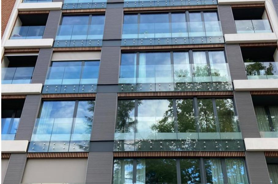
*Figura.- Rehabilitación de fachada de edificio mediante paneles de hormigón. Este edificio situado en la Calle Cardenal Marcelo Spínola de Madrid, ha requerido de 132 paneles de hormigón autoportante de 140 mm de espesor para una extensión de 865 m<sup>2</sup> de superficie*
