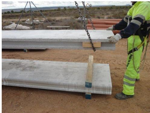
*Figura.- Descarga de placas alveolares*
