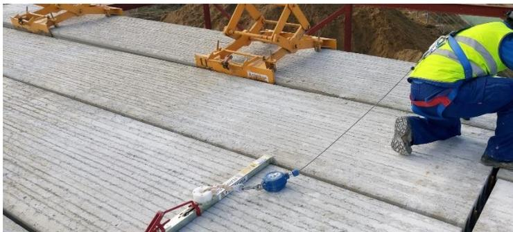
*Figura.- Sistema de pinza de seguridad*
