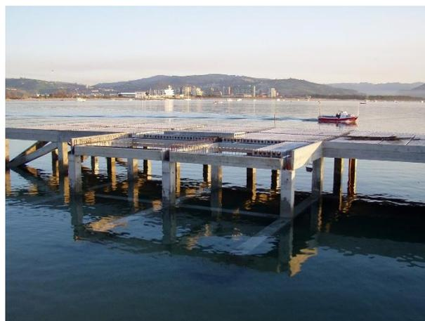
Figura.- Placas alveolares en ambiente marino (corrosión por cloruros)
