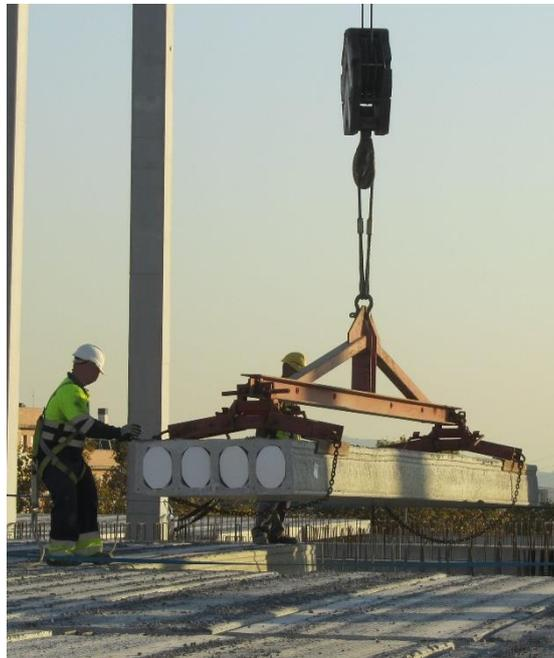
*Figuras.- Montaje de placa alveolar: se suelta la cadena de seguridad antes de colocar en su ubicación definitiva*
