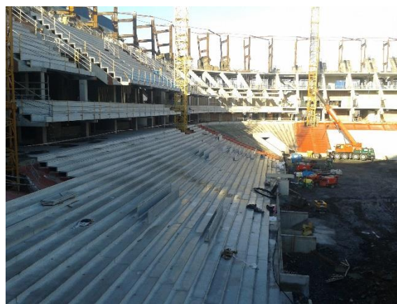
Figura 2.- Nuevo Estadio San Mamés en Bilbao (España). Primer estadio de fútbol europeo con certificación LEED (2013). Cabe destacar la gran importancia de los elementos prefabricados de hormigón: graderíos y prelosas de forjados
