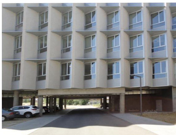
Figura 1.- Edificio LUCIA de la Universidad de Valladolid (España). Premio ENERAGEN 2015 por su alta eficiencia energética y certificado LEED platino, gracias en buena parte al cerramiento pesado de paneles de hormigón prefabricado
