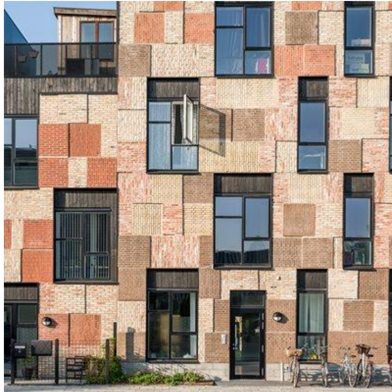
Figura.- En Resources Row en Copenhague, el arquitecto Lendager reutilizó ladrillos viejos moliendo en ángulo secciones enteras de paredes existentes e incrustándolas en paneles prefabricados de fachada
