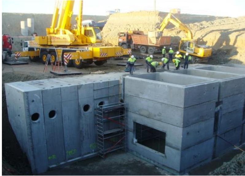
*Figura.- Tanque de tormenta con marcos prefabricados de hormigón*
