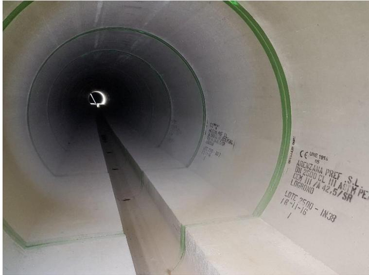
*Figura.- Tubo de hormigón con andén incorporado*
