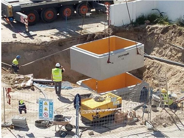
*Figura.- Instalación de arquetas de grandes dimensiones*
