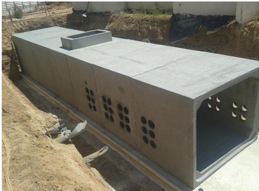
*Figura.- Cámara de empalme de cables eléctricos*
