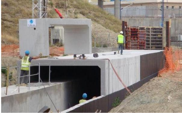
*Figura.- Semimarco colocado de manera individual*
