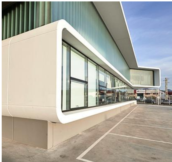
Figura.- Fachada compuesta por panel de cerramiento prefabricado curvo en los encuentros entre sí de esquina
