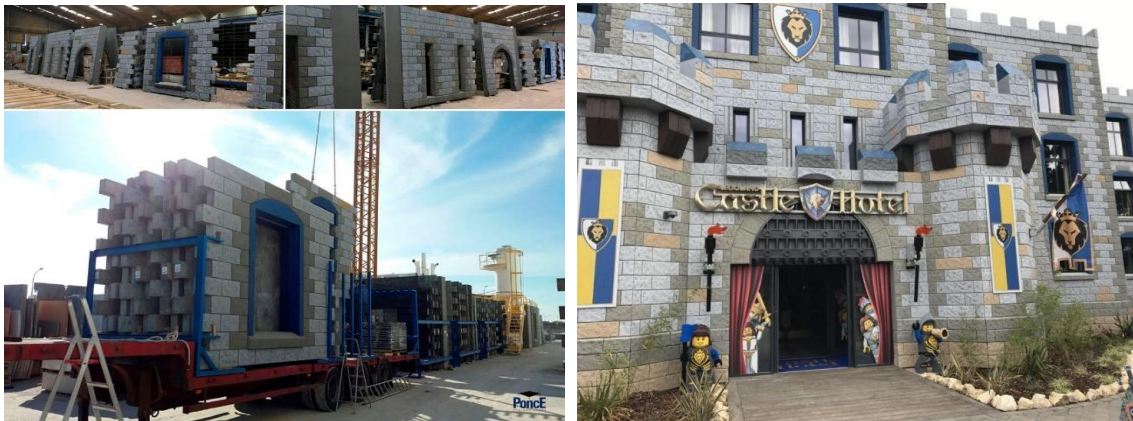
Figura.- 900 m 2 de paneles GRC Sandwich para el Hotel Legoland en Windsor (Inglaterra). Arquitecto: Manser Practice Architects + Designers
