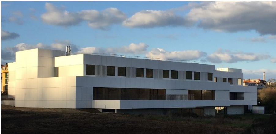
Figura.- Fundación Amancio Ortega. 4.500 m 2 de panel cáscara de GRC en blanco liso y texturizado con anclajes de aluminio para fachada ventilada
