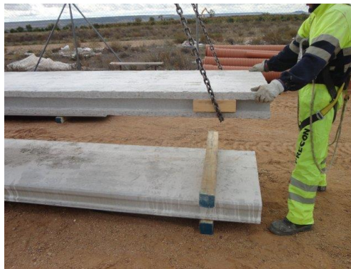
Figura.- Descarga de placas alveolares
