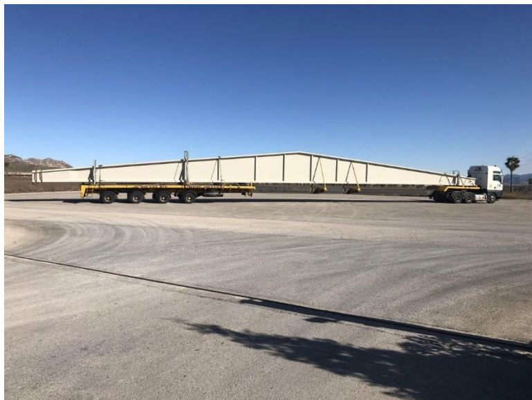
Transporte de viga peraltada de 40 metros
