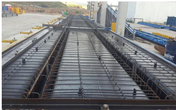
Figura. - Molde para placa TT con la armadura ya colocada y preparada para el hormigonado
