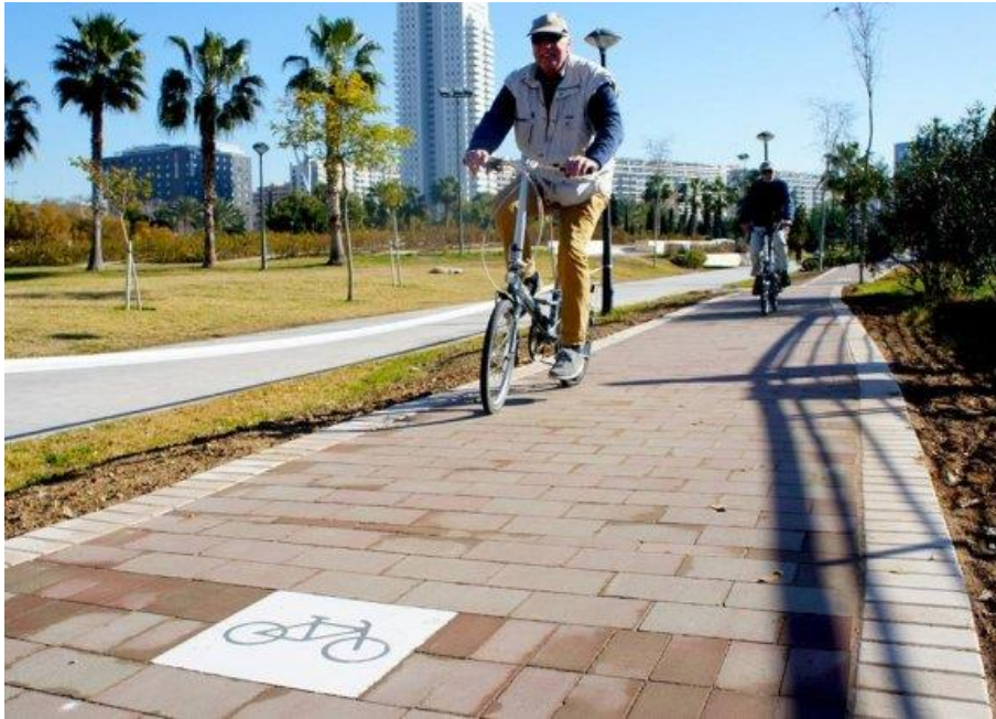
Figura.- Reparación de carril bici en Valencia mediante adoquines prefabricados de hormigón, que garantizan una mayor durabilidad y estabilidad del firme que otras soluciones más continuas
