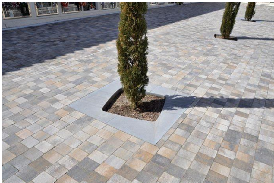
Figura.- Alcorque de hormigón que actúa como embudo o recogedor y trabaja para la captación de agua y aire alrededor del árbol
