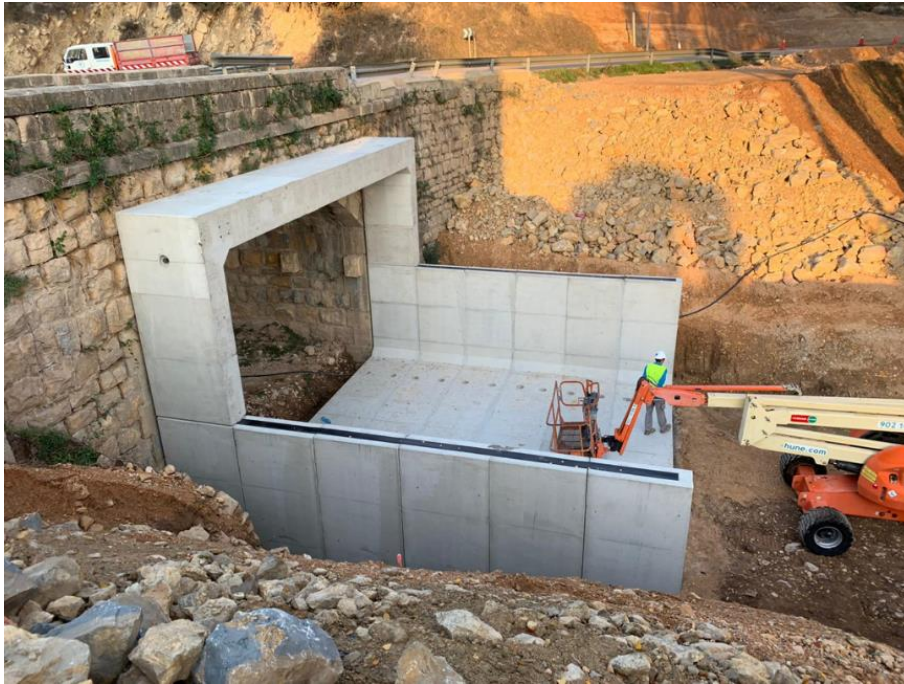
Figura.- Ensanche de un puente existente mediante la colocación de 6,50 metros lineales de marco prefabricado de hormigón
