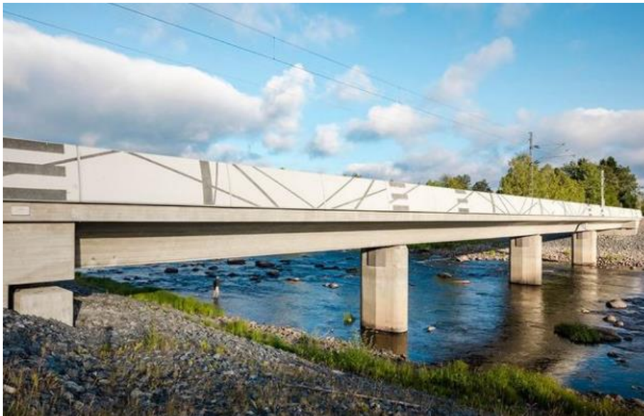
Figura.- Renovación de puente ferroviario con la colocación de paneles prefabricados de hormigón arquitectónico en los laterales. Se mitiga la visión del paso de los trenes, al tiempo que se renueva la estética del puente
