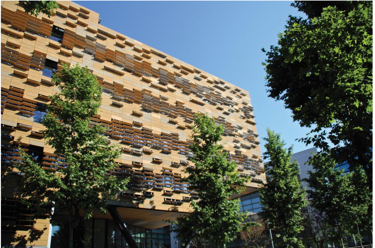
Figura.- Edificio Leitat en Barcelona de PICH ARCHITECTS. La fachada revestida de paneles prefabricados de UHPC, es una envolvente eficiente que da respuesta a los requerimientos físicos de la edificación. El edificio obtuvo una certificación energética A y una certificación ambiental Verde 4 hojas [+]
