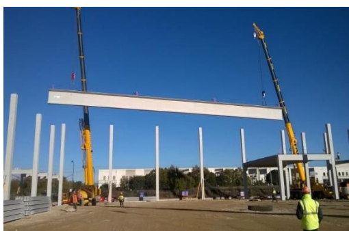
Imágenes.- Estructura prefabricada de hormigón frente a una estructura resuelta in situ. Eficacia en la construcción.
