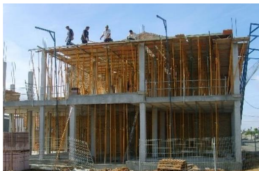
Imágenes.- Estructura prefabricada de hormigón frente a una estructura resuelta in situ. Eficacia en la construcción.
