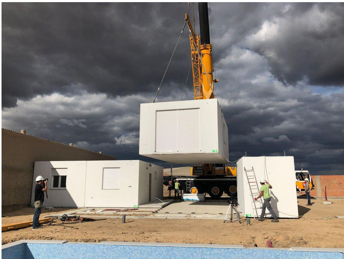
Imagen.- La construcción modular en hormigón reduce al mínimo posible las tareas de obra, siendo la que más rendimiento produce
