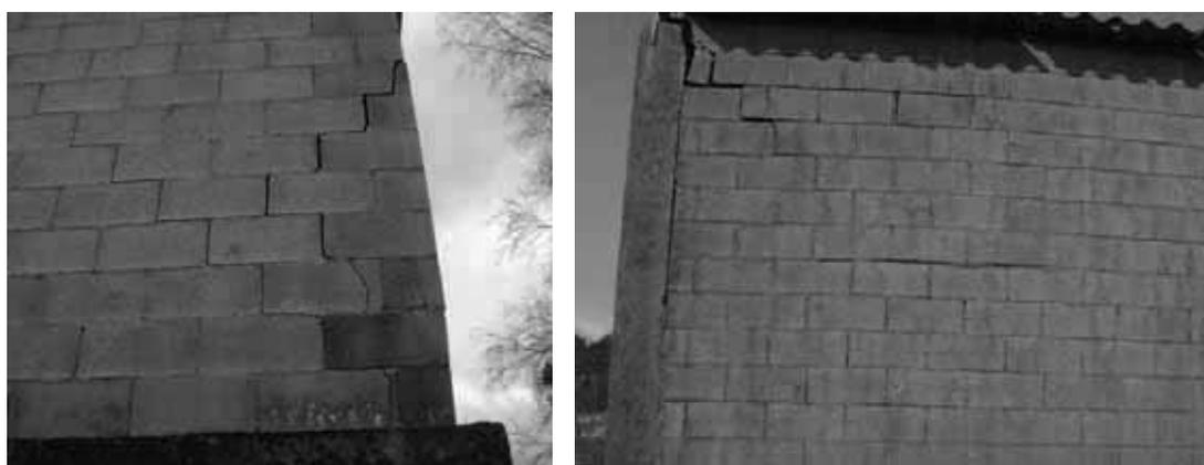
Ilustración 180. Grietas y fisuras por esfuerzos estructurales imprevistos.
