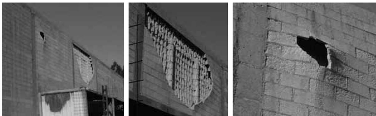
Ilustración 179. Desprendimiento tras el abombamiento de la fábrica.
