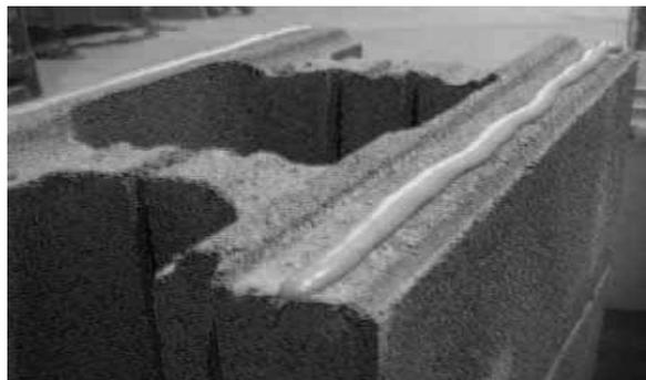
Ilustración 210. Junta pegada mediante adhesivo.
