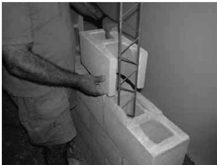
Ilustración 211. Ejecución de un muro acostillado. Colocación de un bloque estándar con una cabeza abierta.
