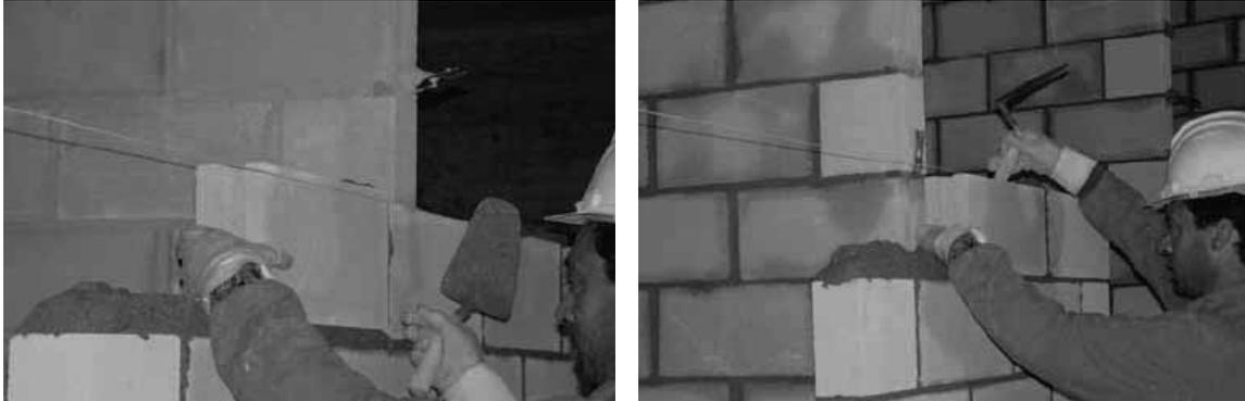
Ilustración 171. Colocación del bloque sobre el mortero de juntas, comprobando siempre el nivel.
