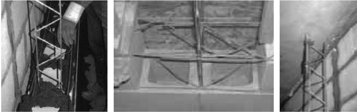
Ilustración 177. Armadura de tendel y costilla vertical [izquierda y centro]. Anclaje de costilla a forjado superior [derecha].
