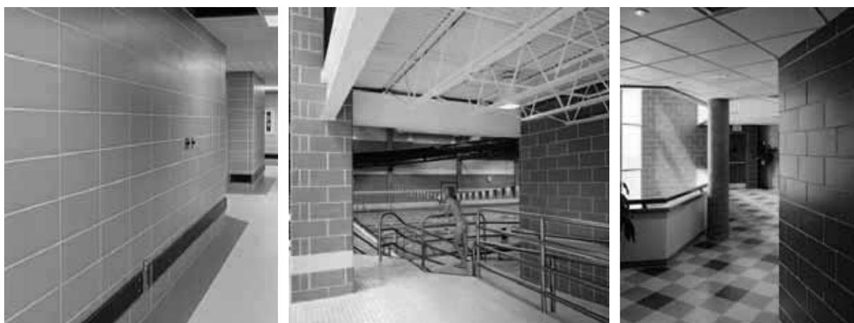
Ilustración 227. Ejemplos con bloque con acabado superficial esmaltado-vitrificado.
