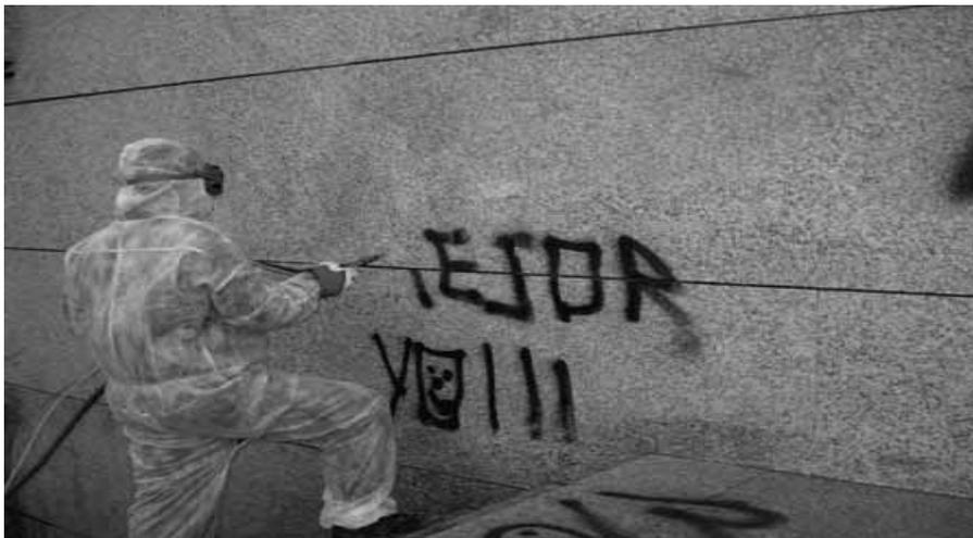
Ilustración 194. Limpieza de pintada con chorro a presión.
