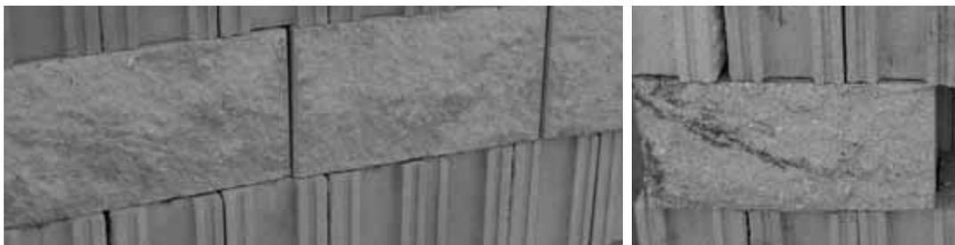
Ilustración 222. Ejemplos de bloques con dos colores.
