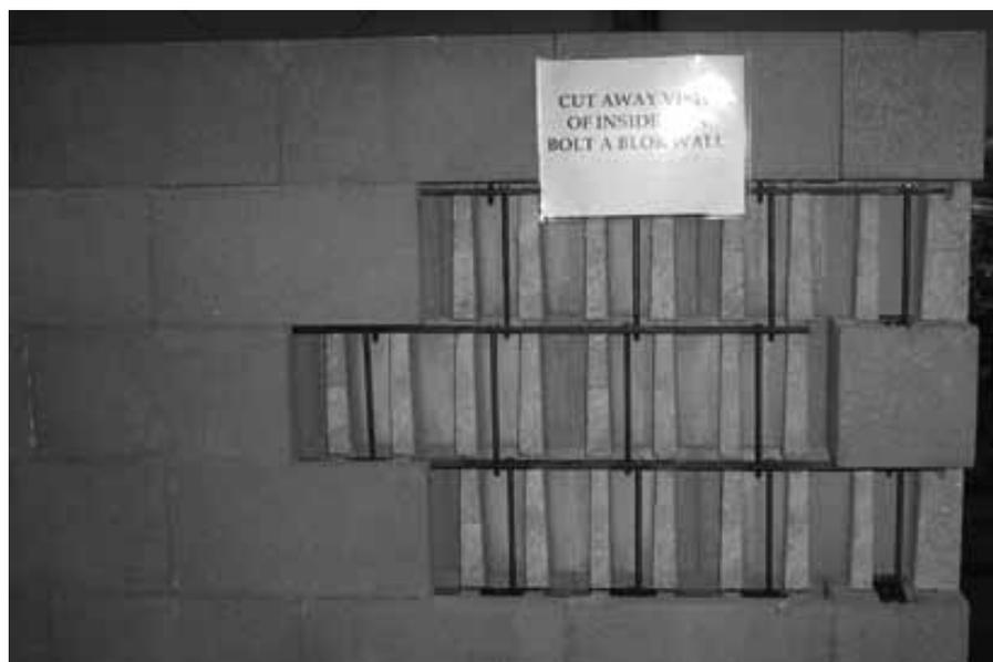
Ilustración 216. Vista del interior de un muro de fábrica de bloque postesada tipo Bolt-A-block, se aprecian las pletinas horizontales y las barras verticales.
