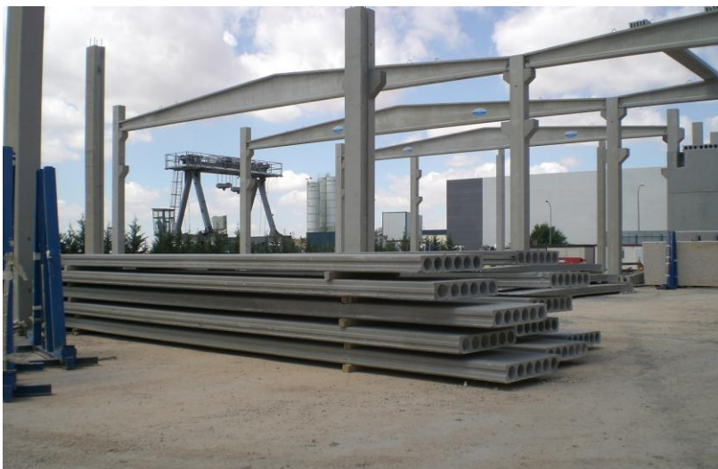
Fotografía – Acopio en obra de placas alveolares antes de su montaje
