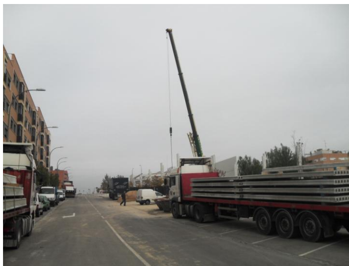
Fotografía – Placas alveolares que serán montadas directamente desde el camión que las ha transportado
