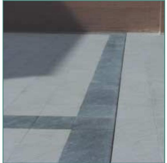
Estas juntas de dilatación suelen estar constituidas por un perfil de manera que asegure la continuidad del pavimento.
