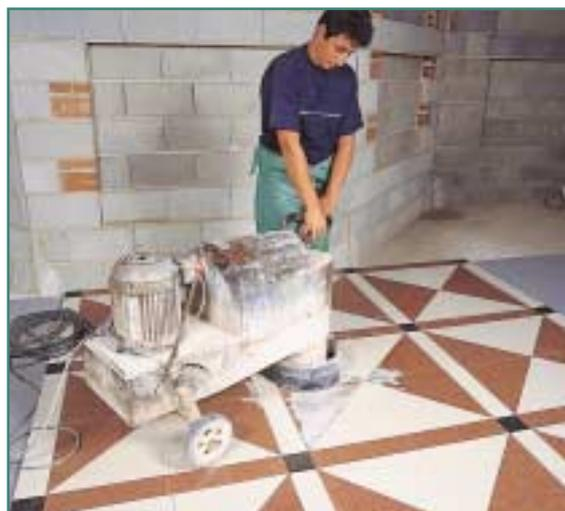
Debido al diseño de las pulidoras, generalmente no pueden acceder a los bordes del pavimento, por lo que será necesario proceder a un pulido manual de los mismos, operación que suele realizarse en seco mediante pulidoras manuales.
