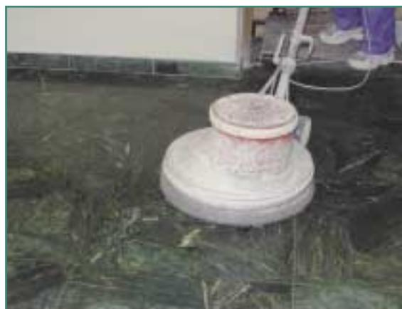
En las superficies "cristalizadas", dependiendo del uso al que se somete el pavimento, es recomendable aplicar periódicamente un abrillantado mecánico que permita devolver a la superficie su aspecto original. El proceso a seguir es como sigue:
