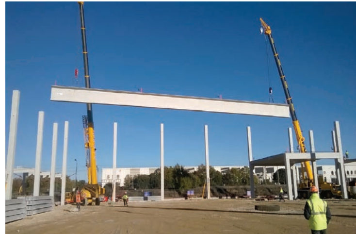
Figura 7.- Montaje vigas prefabricadas de hormigón de longitud hasta 55 metros, para estructura en la nueva factoría de Campofrío. PRECON
