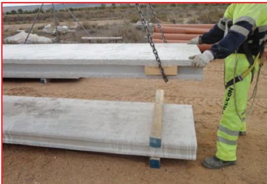
Figura 6.- Descarga de placas alveolares
