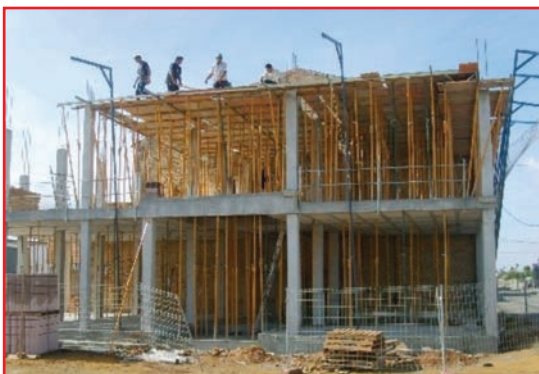
Figura 1.- Construcción in situ
