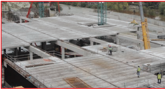
Figura 3.- Montaje de forjado prefabricado
