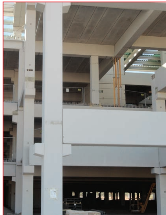
Figura 4 y 5.- Montaje de prefabricados
