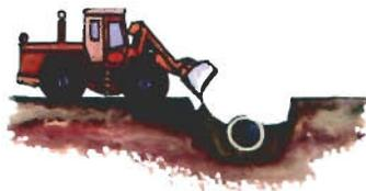
El material de relleno, adecuado, se coloca con cuidado a lo largo del tubo y se compacta bajo los rinones. El material se aportará por sucesivas capas a los dos lados del tubo y unos 30 cm por encima de la generatriz superior del tubo.
