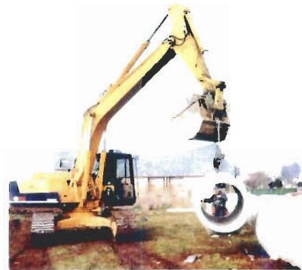
Figura 5.5.6.a Instalación de tubos con retroexcavadora
