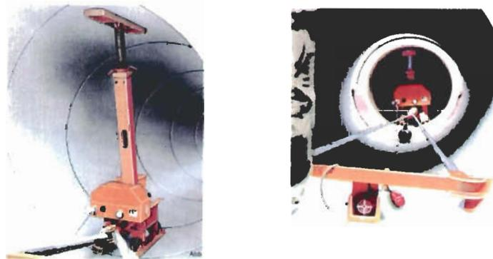
Figura 5.5.6.e Montaje con tráctel electrohidráulico
