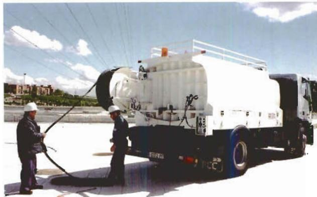
Figura 6.1 Mantenimiento urbano de alcantarillado
