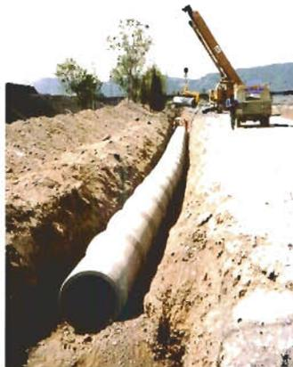
*Figura 5.5.4.a Maquinaria de descenso de tubos a zanja*
