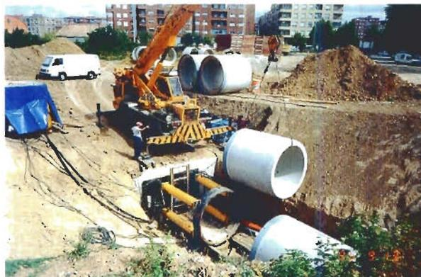
La longitud de una perforación viene condicionada por la máxima presión que pueden desarrollar los cilindros y, por otra parte, por la resistencia que ofrece la compresión longitudinal de la tubería, tal como se indica en el apartado 3.9.4.4.
