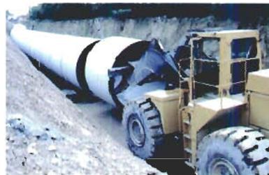
Figura 5.5.6.g Montaje de tubos con carretillas elevadoras
