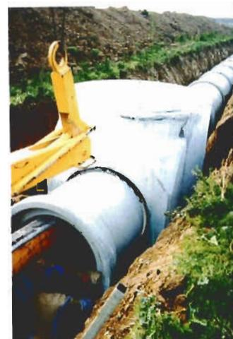
Para la elección del tipo de armado que debe colocarse en los módulos de los pozos la Asociación de Abastecimientos de Agua y Saneamiento (AEAS) ha considerado varios factores que provocan que no se produzca una presión radial uniforme sobre la cara exterior del módulo. Estos factores y su incidencia vienen reflejados en la siguiente tabla:
