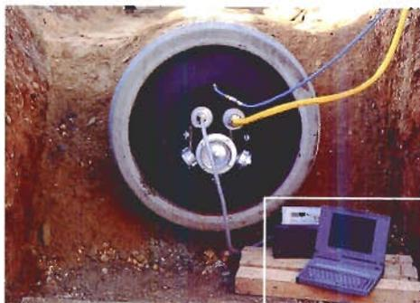
Figura 5.8.4.b Balón obturador de tuberías con "by pass"
