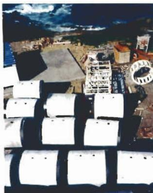
Los procedimientos preventivos para evitar flotación consisten en aumentar el grosor del tubo, aumentar la densidad del hormigón o diseñar una serie de sujeciones del tubo al suelo, de forma que aumenten el peso del tubo o mejoren la fijación.
