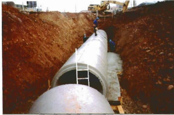
Para cualquier tipo de instalación el valor de  $q_r$  correspondiente a terraplén representa la máxima carga que el relleno produce sobre la conducción.
