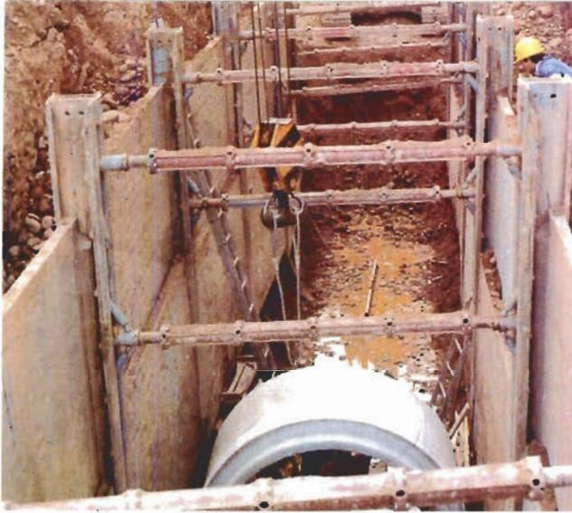
Cuando existen terrenos superiores sueltos (generalmente diluviales o de acarreos) sobre otros compactos y, sobre todo (como es frecuente en las calles), la capa superior es de relleno y la inferior compacta, puede hacerse una entibación parcial, cuajada en la parte superior. Con ello queda libre la zona de trabajo propiamente dicha, que no suele presentar entibación o ésta puede ser mínima.
