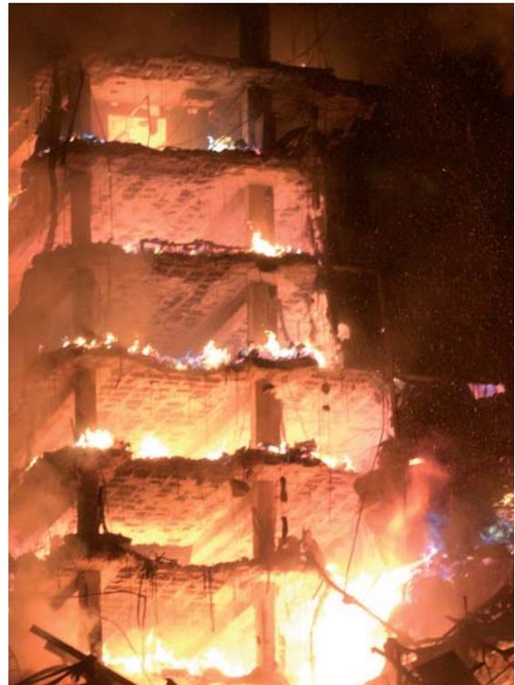
tencia del edificio que evita su colapso, ya que de estos ensayos se ha podido inferir que la estructura de hormigón estuvo sometida a temperaturas en el entorno de los 1.000 °C.
