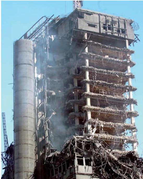
Foto 5, 6, 7 y 8.- Interior del Edificio Windsor después del incendio.
