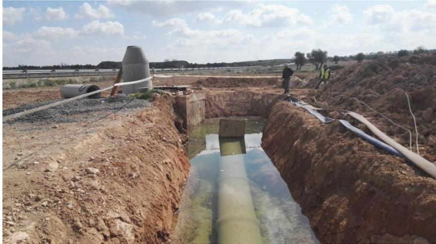
Figura 1: Tubos de hormigón en zonas situadas bajo el nivel freático.
