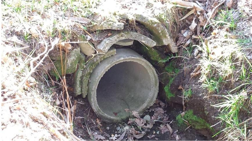
Figura 3: Tubo de hormigón en cruce con deficiente instalación.
