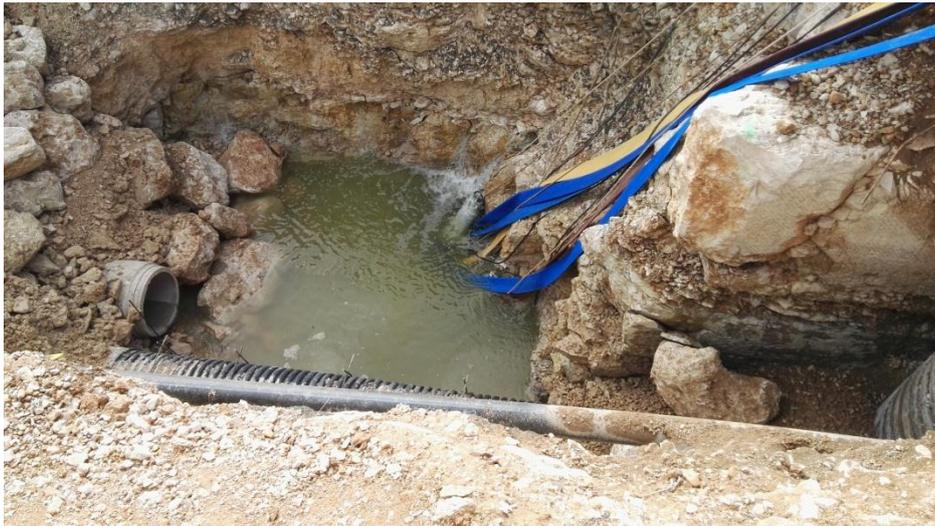
Figura 2: Instalación de tubos de hormigón armado autoresistente.
