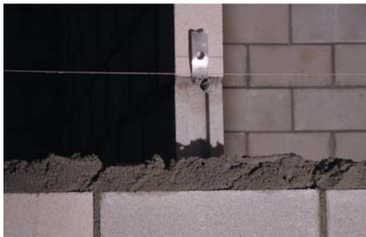
Los bloques se llevarán a su posición mientras el mortero está aún blando y plástico, quitándose el mortero sobrante con la paleta sin ensuciar ni rayar el bloque. Los bloques que queden mal colocados o removidos, deben ser levantados y colocados de nuevo.
