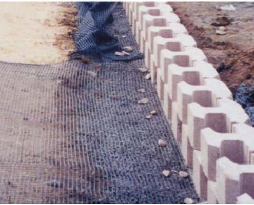
Los muros de contención se constituyen por sillares de hormigón colocados en seco y aparejados de forma que utilizan principalmente su peso propio para conseguir estabilidad. Pueden complementarse con refuerzos embebidos en el terreno para prevenir vuelcos o deslizamientos.
