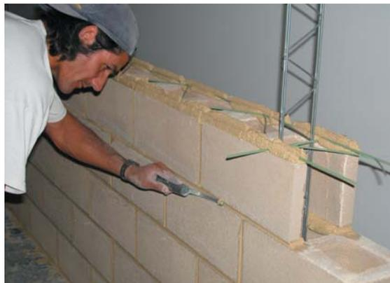
En fábricas de bloques huecos, las juntas no se rehundirán más de 1/3 del espesor de la pared exterior del bloque.
