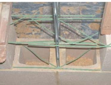
En la puesta en obra, habrá que comprobar que se logra el afianzado de las fijaciones a las costillas, apretando correctamente las tuercas entre ellas.
