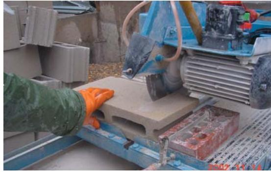
Cuando sea necesario, los bloques se cortarán limpiamente con maquinaria adecuada para cumplir los requisitos dimensionales y mantener un aspecto uniforme. Se procurará reducir el corte de piezas lo más posible, ajustando las dimensiones de la fábrica a las dimensiones de modulación del bloque.
