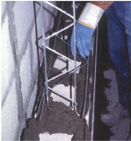
Puede evitarse solapar en la costilla, modulando los niveles de los tendeles de la fábrica con la triangulación de las costillas verticales, o bien enhebrando de arriba a abajo las armaduras de tendel a lo largo de las costillas, si las cerchas de tendel son de igual o mayor ancho que la costilla.
