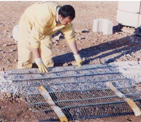
En cualquier caso, la dirección resistente debe ser perpendicular a la cara del muro y no se deben empalmar mallas en esta dirección. Las mallas adyacentes en la dirección perpendicular al muro se colocarán a tope.
