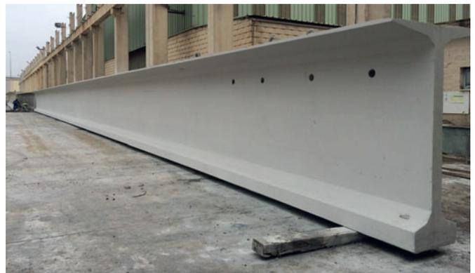
*Elementos prefabricados de hormigón destinados a construcciones avanzadas, que aseguran altos niveles de calidad.*
