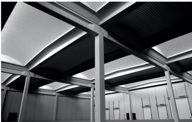
*Diseño limpio y estéticamente atractivo mediante elementos prefabricados de hormigón.*
