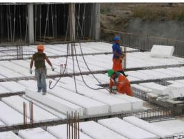
Prelosas pretensadas: losas con dos o más nervios rigidizadores continuos, generalmente en la dirección longitudinal para aportar resistencia y rigidez en situaciones transitorias. Los anchos suelen ser de 600 m o de 1.200 mm.
