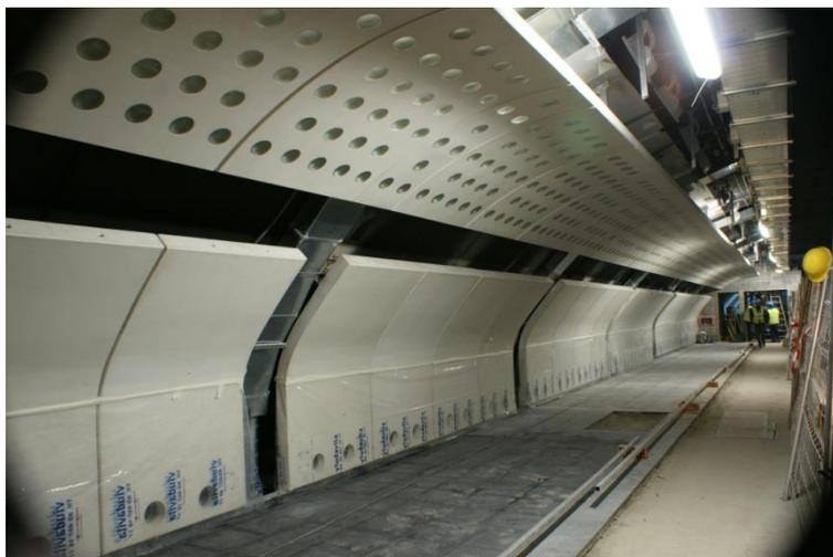
*Figura.- Revestimiento interior línea de metro en Barcelona (España). Fabricación y suministro de paneles de ESCOFET*
