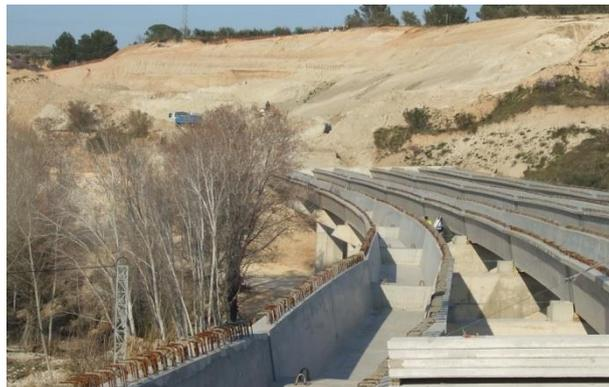
En el caso de tableros de mayor anchura o por motivos de resistencia se pueden fabricar vigas artesa de cajón multicelular, divididas longitudinalmente en varias partes que se unen con junta “in situ” en las losas superior e inferior. También conocidas como vigas asimétricas adosadas, el rango de uso de esta aplicación está en torno a los 14 m en puentes de ferrocarril, pudiendo llegar a mayores anchuras (< 24 m) en carreteras mediante la ayuda de apoyos laterales (jabalcones).
