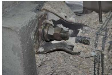
Figura 11: Vista de detalle de la doble tuerca en la unión “Tornillo”
