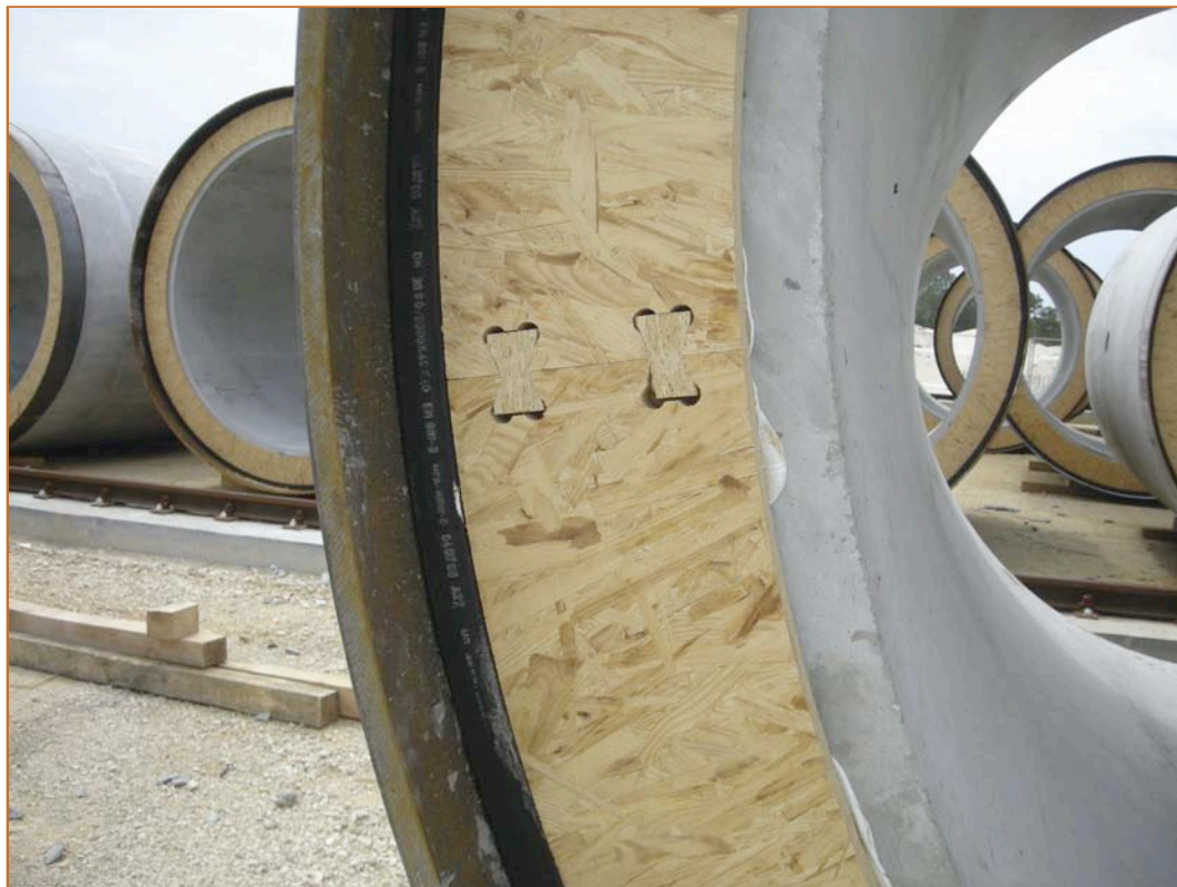
Figura 6. Junta taco y sufridera de OSB
