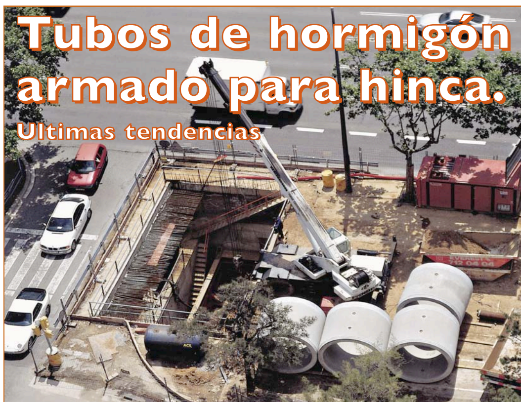
Figura 1. Pozo de hinca
