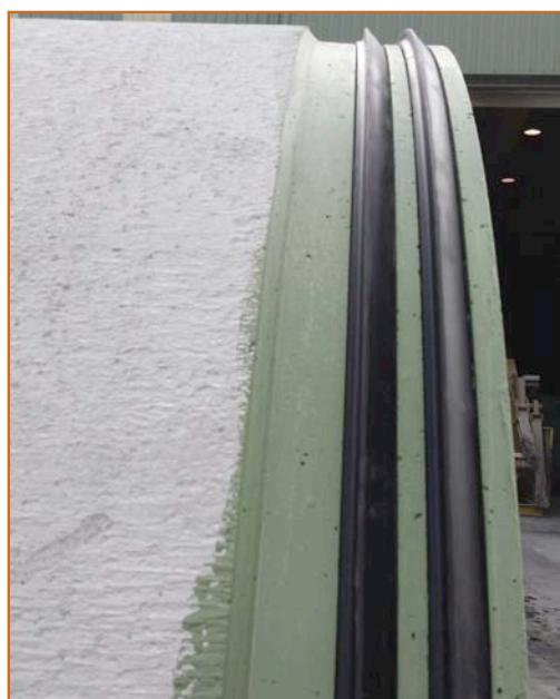
Figura 4. Doble junta en espiga
