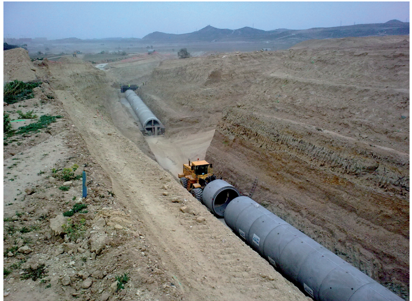
FIGURA 6. Ejecución de obra.
