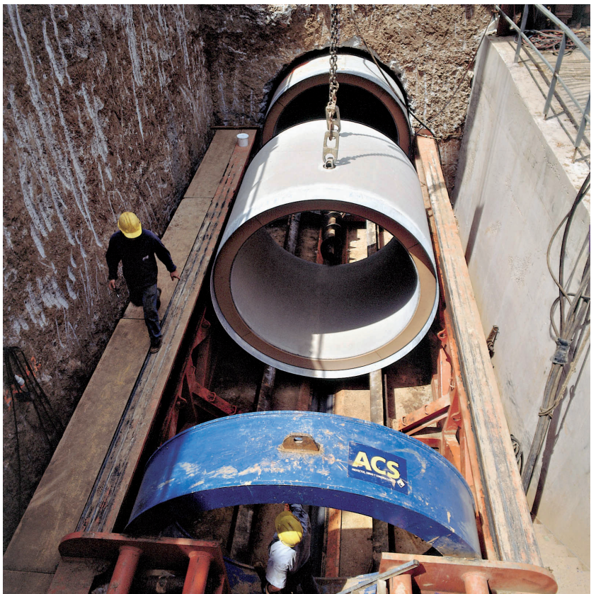
FIGURA 7. Obra de tubo colocado en hincas.
