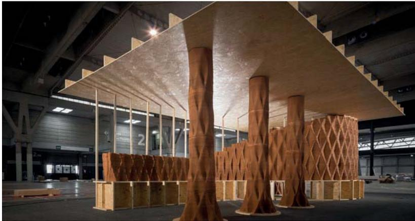
Figura 4. Sistema constructivo mediante impresión 3D ejecutado durante la feria CONSTRUMAT 2017. Cortesía de TECNALIA e IAAC.
