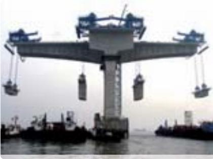
Construcción de un puente off-shore mediante el empleo de cajones prefabricados de hormigón para la formación del tablero.
