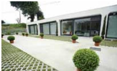
Construcción modular bioclimática mediante marcos prefabricados de hormigón. Fuente: BIOCLIMÁTICA MODULAR CONCEPT.
