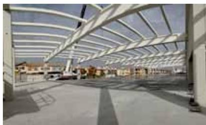
Estructura de nave industrial íntegramente resuelta mediante elementos prefabricados de hormigón. Foto cortesía de PRETERSA PRENAVISA.
