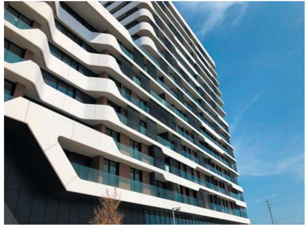
*Edificio 'El Rengle' en Mataró (Barcelona), cuya parte ciega de las fachadas ha sido resuelta mediante paneles de GRC con formas rectas y curvas. (Foto: Prefabricats Planas).*
