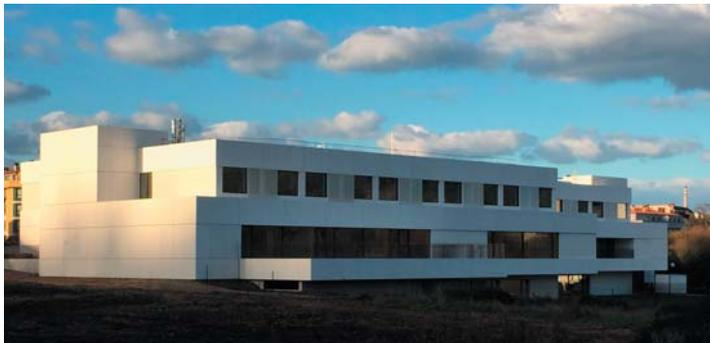
*Fundación 'Amancio Ortega' (Inditex) en Arteixo (La Coruña). Se trata de 4.500 m<sup>2</sup> de panel cáscara de GRC en blanco liso y texturizado con anclajes de aluminio para fachada ventilada. (Foto: Prefabricados Ponce).*
