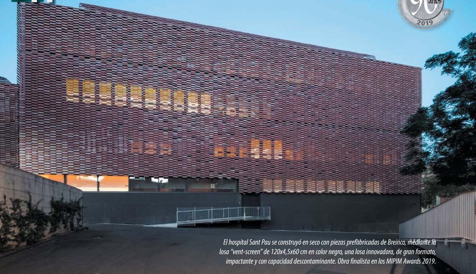
*El hospital Sant Pau se construyó en seco con piezas prefabricadas de Breinco, mediante la losa "vent-screen" de 120x4,5x60 cm en color negro, una losa innovadora, de gran formato, impactante y con capacidad descontaminante. Obra finalista en los MIPIM Awards 2019.*
