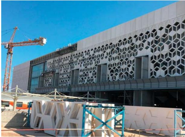
*Nueva estación del tren de alta velocidad LGV Rabat-Agdal (Marruecos). 800 paneles prefabricados de altas prestaciones armados con fibra UHPC de 2.000 mm de ancho y más 7.500 mm de alto en forma de celosía y doble piel del muro cortina. (Diseño de Youssef Melehi y ejecutados por Prehorquisa).*
