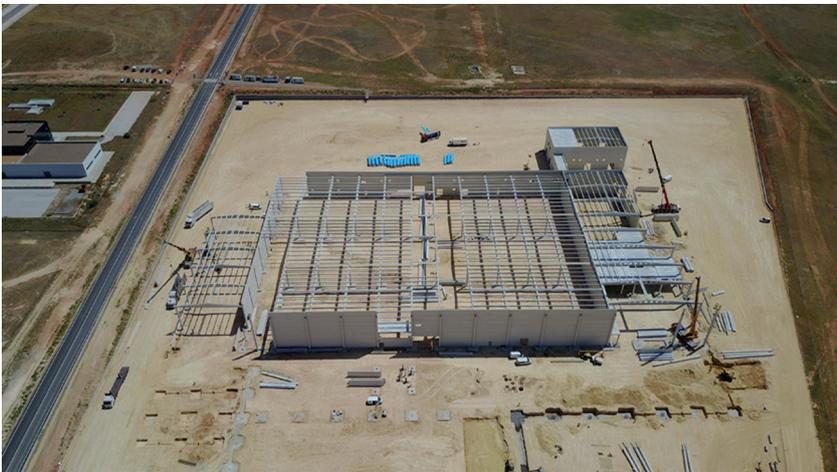
Figura 1.(a la izquierda). Vista área de la construcción de la nueva fábrica del GRUPO YBARRA en Dos Hermanas (Sevilla). Estructura y cerramientos íntegramente realizados mediante elementos prefabricados de hormigón, una de las aplicaciones más consolidadas por su grado máximo de industrialización y sus ventajas asociadas (velocidad de ejecución, control, seguridad, nulos residuos, etc.) Foto cortesía de PRETERSA PRENAVISA.
