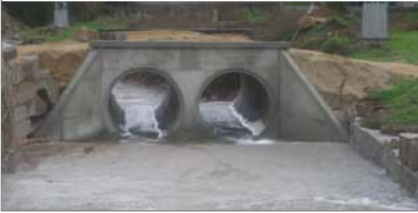
Figura 6. Obra de drenaje transversal.
