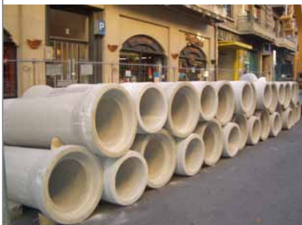
Figura 8. Tubos circulares de campana acopiados en obra.
