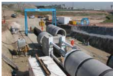
Figura 4. Hinca de tubos de hormigón armado.
