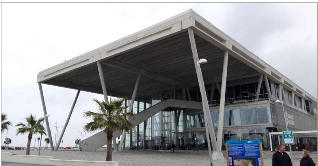
■ Figura 4. Estación marítima de Denia (Alicante). Una de las obras recientes más singulares proyectadas con elementos prefabricados de hormigón de alta resistencia.
