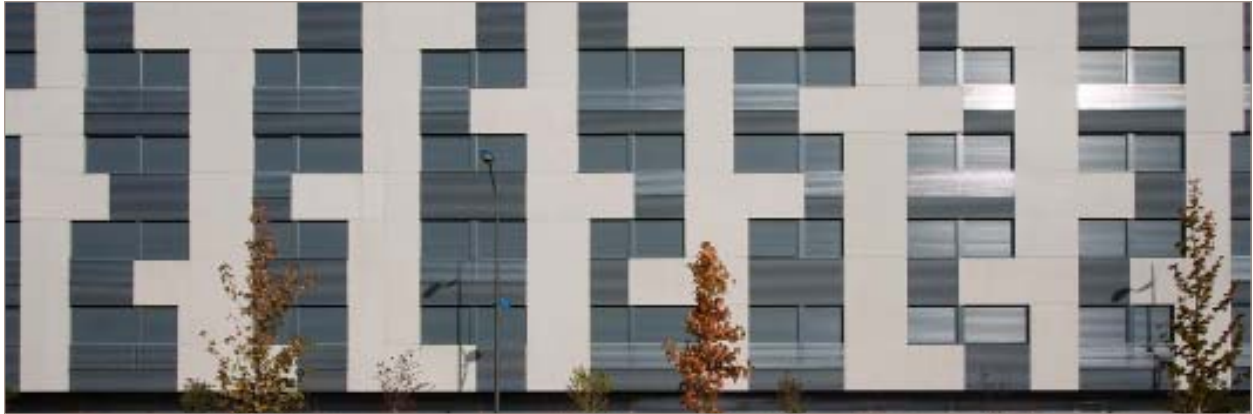
■ Figura 3. Fachada industrializada en hormigón prefabricado. Un buen ejemplo de construcción que combina idóneamente la estética con las prestaciones.
