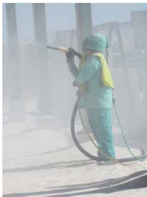
FIGURA 36 - POSICIÓN DURANTE LOS TRABAJOS DE PULIDO
