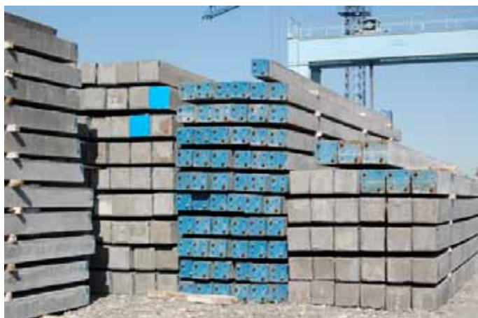
FIGURA 33 - ACOPIO DE PILOTES PREFABRICADOS
