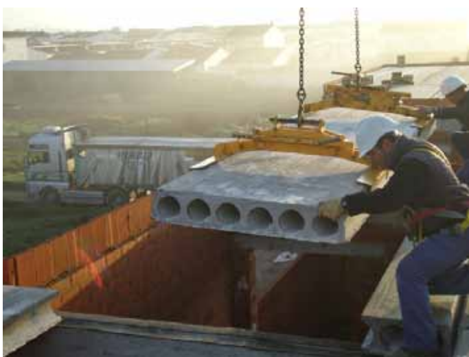
FIGURA 47 - TRABAJADOR DIRIGIENDO TRABAJOS DE MONTAJE DE ELEMENTOS PREFABRICADOS
