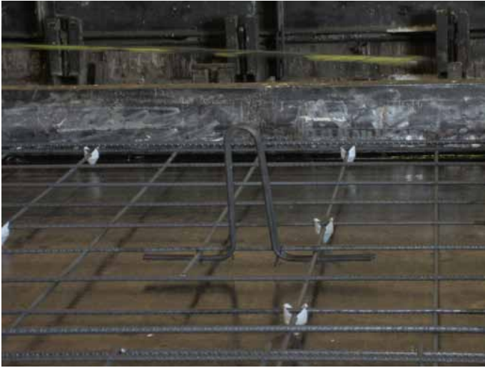
FIGURA 4– DETALLE Y CESTA DE CACHAVAS PARA POSTERIOR IZADO DURANTE EL DESECOFRADO
