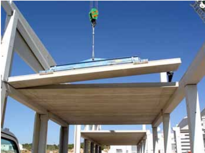
FIGURA 22 - MONTAJE DE NAVE INDUSTRIAL
