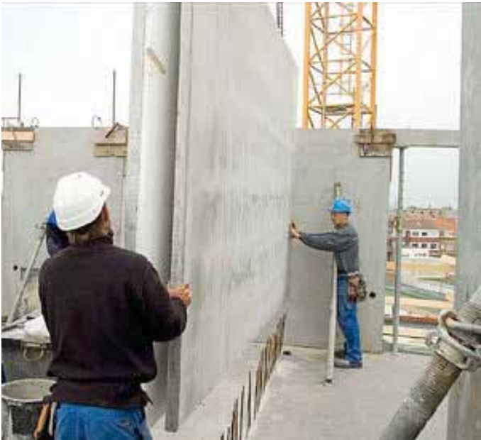
FIGURA 44 - POSICIONAMIENTO DE ELEMENTOS PREFABRICADOS
