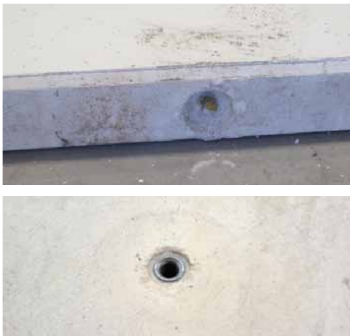
FIGURA 27 - PUNTOS DE ANCLAJE PARA MANIPULACIÓN: BULÓN Y SISTEMA ROSCADO
