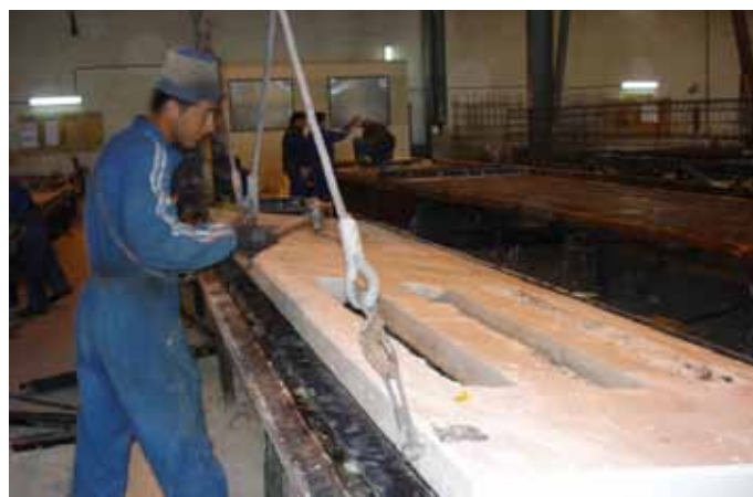
FIGURA 29 - DESMOLDADO DE PREFABRICADO
