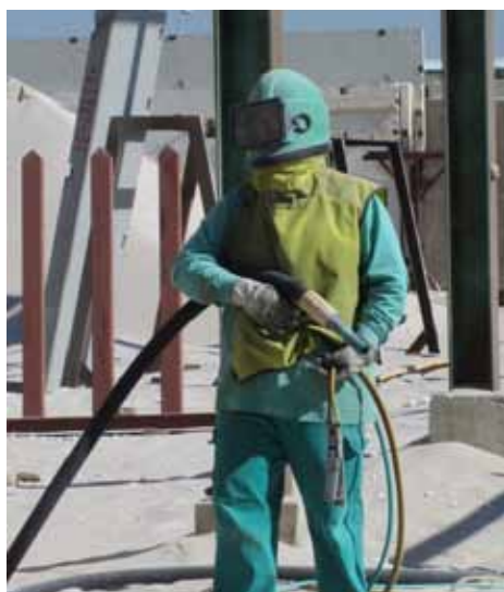
FIGURA 35 - EQUIPO PARA PULIDO DE PREFABRICADO
