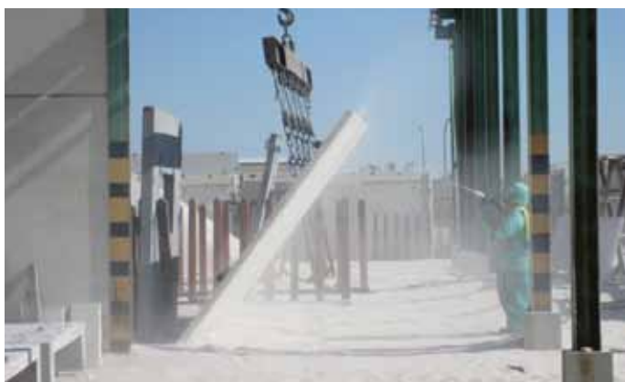
FIGURA 34 - PULIDO DE PREFABRICADO POR CHORRO DE ARENA
