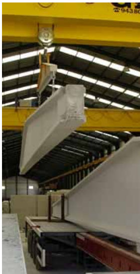
FIGURA 37 - CARGA DE VIGA DELTA EN CAMIÓN DE TRANSPORTE
