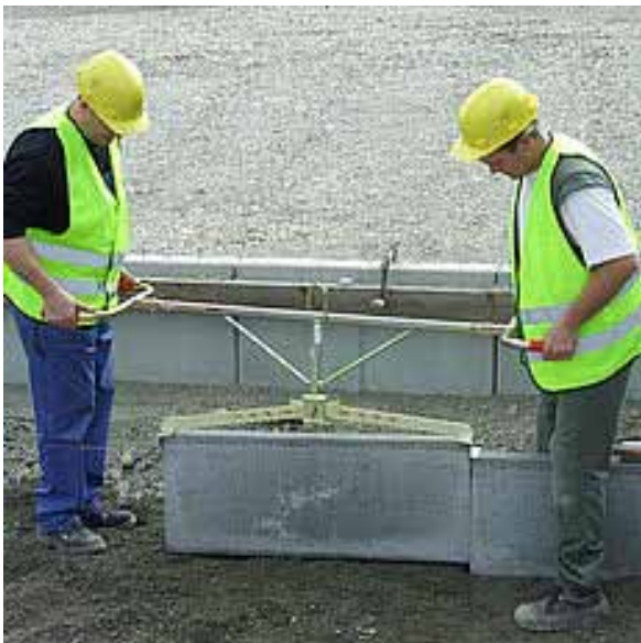
FIGURA 52 - COLOCACIÓN DE PREFABRICADOS MEDIANTE ELEMENTO AUXILIAR
