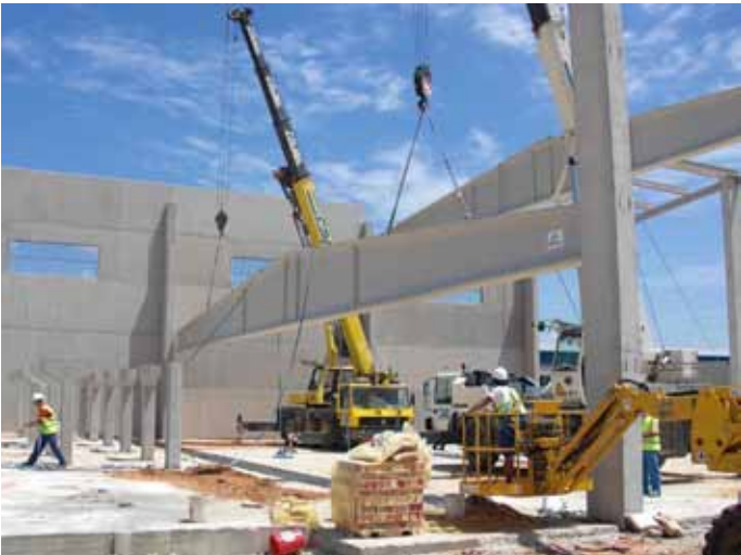
FIGURA 21 - MONTAJE NAVE INDUSTRIAL PREFABRICADA
