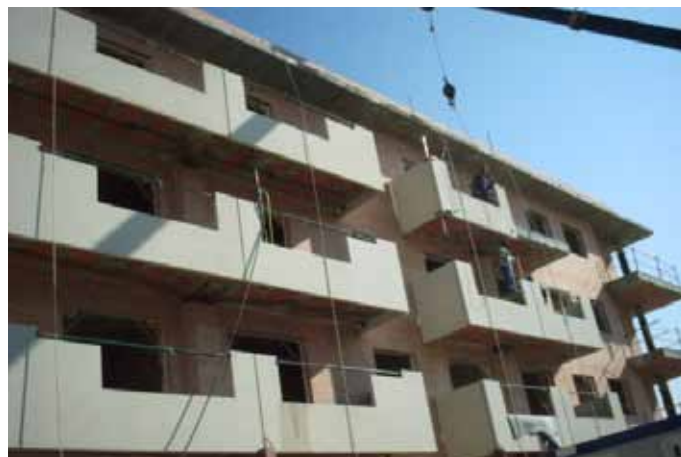
FIGURA 46 - TRABAJOS DE FORRADO DE BALCONES
