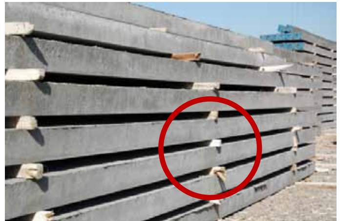
FIGURA 32 - CUÑAS DE SEPARACIÓN EN ACOPIO DE PILOTES
