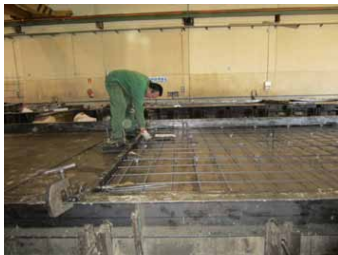
FIGURA 23 - TRABAJOS DE COLOCACIÓN DE COMPONENTES DE LA PIEZA
