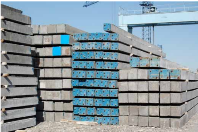
FIGURA 31 - ACOPIO DE PILOTES PREFABRICADOS
