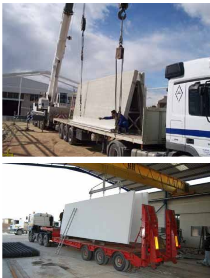
FIGURA 40 - TRABAJOS DE CARGA DE CAMIÓN
