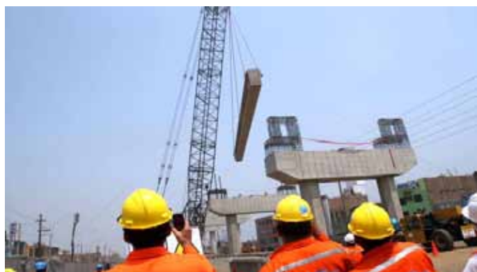
FIGURA 53 - TRABAJOS DE MONTAJE EN PRESENCIA DE LÍNEAS ELÉCTRICAS ÁEREAS
