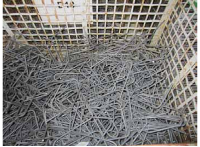
FIGURA 4– DETALLE Y CESTA DE CACHAVAS PARA POSTERIOR IZADO DURANTE EL DESECOFRADO
