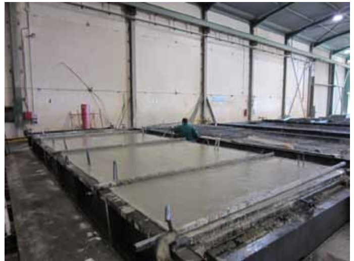
FIGURA 6 – VERTIDO DE HORMIGÓN SOBRE MOLDE
