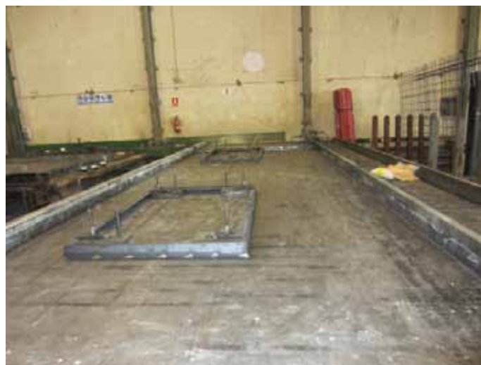
FIGURA 3 – ADAPTACIÓN DE MOLDE PARA FORMA ESPECÍFICA: PANEL DE FACHADA CON HUECO DE VENTANA
