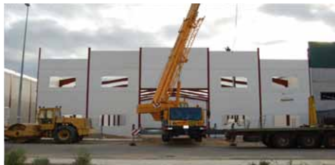
FIGURA 45 - MONTAJE DE MUROS PREFABRICADOS
