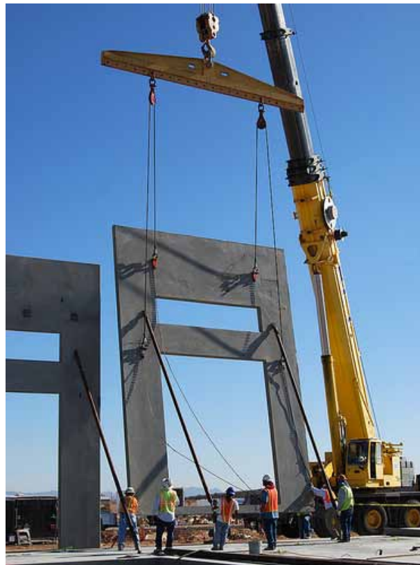
FIGURA 50 - TRABAJOS DE MANIPULACIÓN Y POSICIONAMIENTO DE PIEZAS PREFABRICADAS
