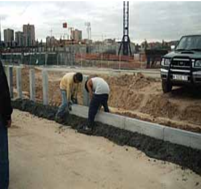
FIGURA 51 - COLOCACIÓN DE PREFABRICADOS MANUALMENTE
