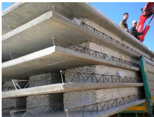
FIGURA 43 - TRABAJOS DE DESCARGA DE LOSAS PREFABRICADAS CON TRABAJADORES SOBRE LA CARGA
