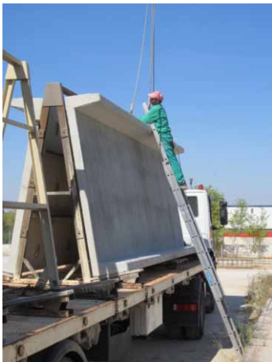
FIGURA 42 - ESCALERA PARA EL ACCESO A LA COTA SUPERIOR DE LA PIEZA Y MANIPULACIÓN DE LA MISMA
