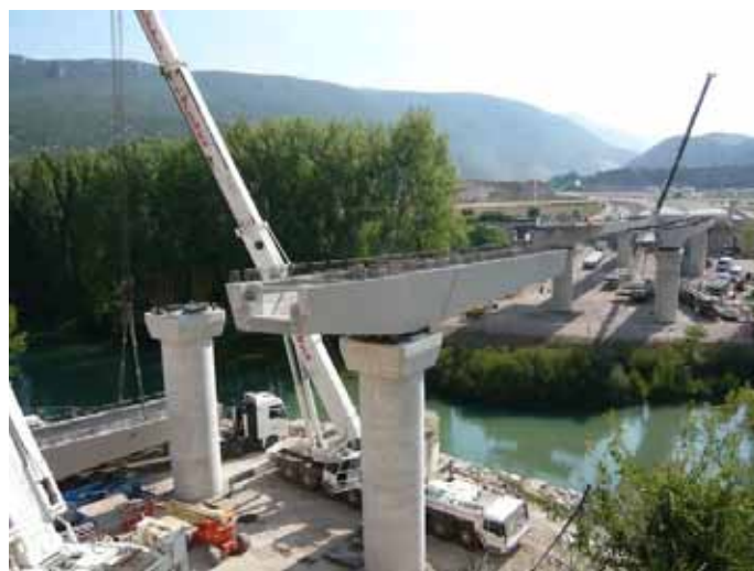
FIGURA 20 - MONTAJE PUENTE PREFABRICADO DE VIADUCTO
