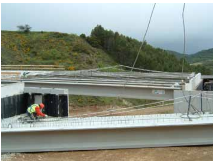
FIGURA 48 - MONTAJE DE VIADUCTO
