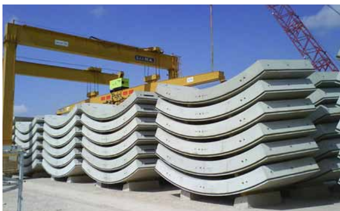
FIGURA 10 - DEPÓSITO DE DOVELAS
