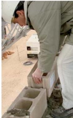
**Correcta orientación de las piezas:** normalmente las piezas tiene alveolos interiores de forma cónica. Es importante que el bloque se coloque de tal manera que quede en la parte superior aquel lado que tenga las paredes más gruesas para poder colocar sobre ellas el mortero de las juntas.
