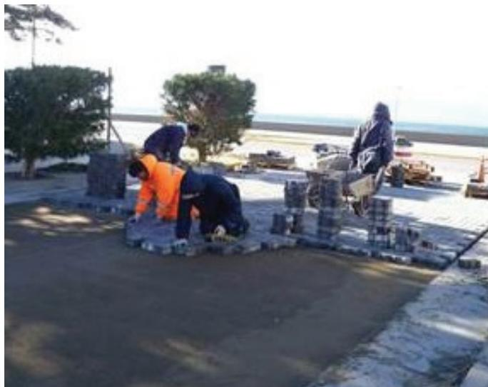
Los adoquines se colocan sin ningún tipo de aglomerante. Las juntas, cuyo ancho debe oscilar entre 2 y 3 mm, deben rellenarse con arena tal y como se explica posteriormente.
